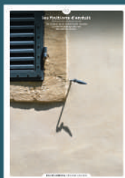
02 les finitions d'enduit
