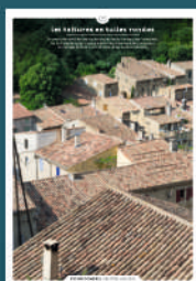
05 les toitures en tuiles rondes
