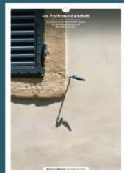
02 les finitions d'enduit
