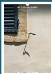
02 les finitions d'enduit
