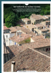
05 les toitures en tuiles rondes
