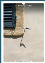
02 les finitions d'enduit
