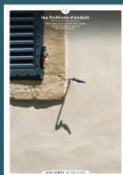
02 les finitions d'enduit
