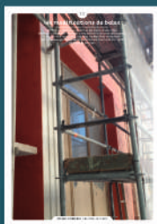
13 les modifications de baies
