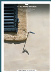
02 les finitions d'enduit
