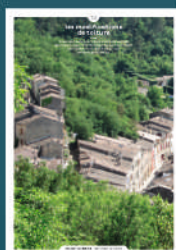
14 les modifications de toiture
